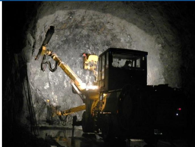
de 9,6 m de ancho x 9,8 m. Inicialmente, se detonó un túnel de alivio más pequeño, de 5 m x 6 m, en la sección media superior de la excavación más grande del túnel.
